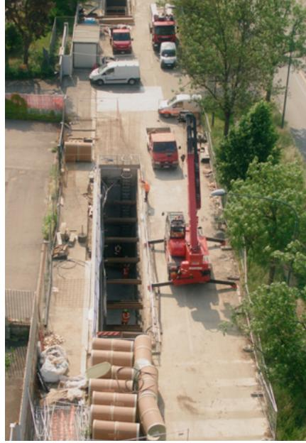
L'ottima scabrezza degli elementi, nonostante la minima riduzione della sezione idraulica, permette di migliorare la capacità di flusso del collettore di circa il 10%.
